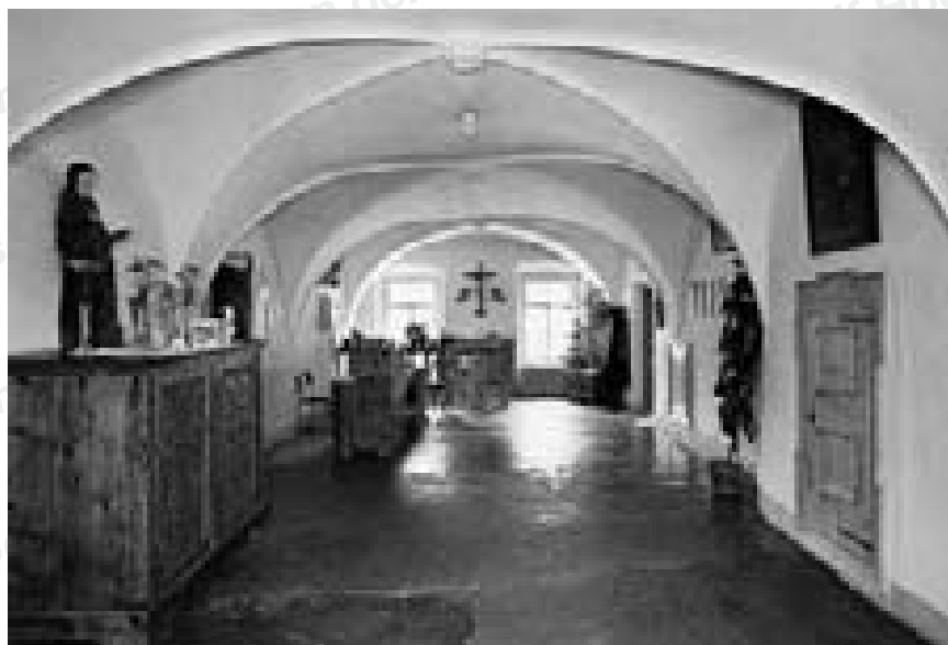
42 Gewölbte Pforten-Halle von 1626 im ersten Obergeschoss des Westtraktes. Wände und Gewölbe sind überweisselt; sie waren ursprünglich mit pflanzlichen Motiven bemalt. Im Hintergrund links die Brettbaluster des Geländers vor der Treppe aus dem Erdgeschoss (von der Pforte her). Aufnahme 1987 (Foto S. Fibbi-Aeppli, Grandson).
