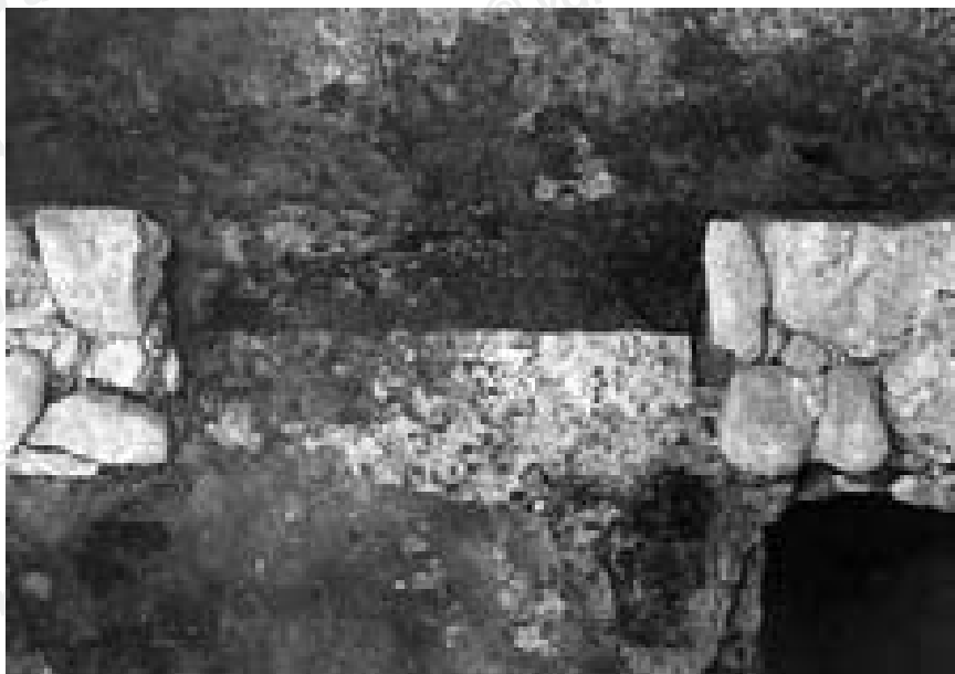
23 Karolingischer Südtrakt, Grabungs- etappe Kindergarten 1992. Senkrechtaufnahme der Reste einer Türe, die vom Gang (unten) in einen der Räume des südlichen Konventtraktes führte. Der Mörtelboden des Raumes zieht sich ins Türlicht hinein und schliesst an einer verkohlten Holzschwelle an. Links ist zwischen Türwange und Mörtelboden eine rechteckige Aussparung zu erkennen, die vom hölzernen Türgericht herrührt.
