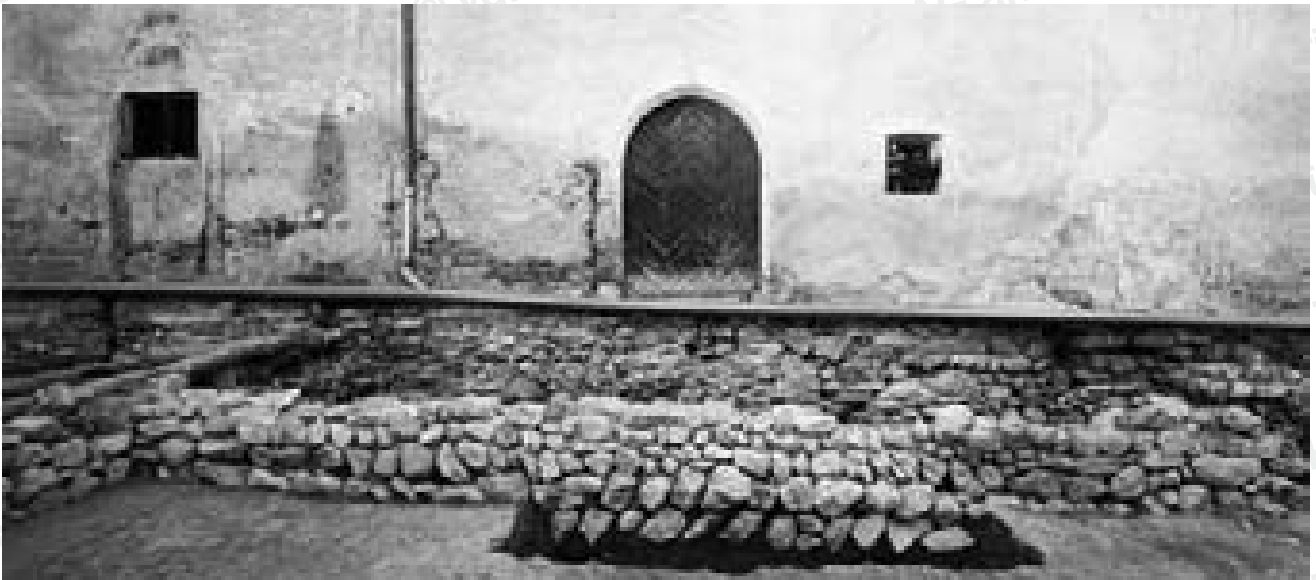
22 Ausgrabung Westhof 1973. Fundament und Aufgehendes eines karolingischen Mauerstückes von der Ostmauer des grossen Saalgebäudes vor dem heutigen Westtrakt, dessen Fassade im Hintergrund zu sehen ist. Hier sind die trocken verlegten Steine der untersten Lage schräggestellt.
