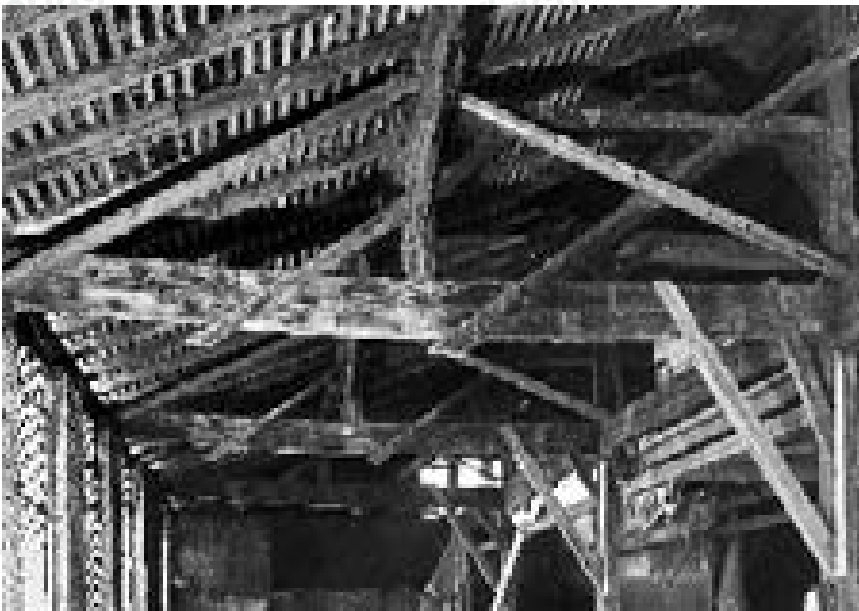
4 Nordstall, Dachstuhl von 1503 (Ausschnitt). Rafen, Lattung und helle Streben und Stützen sind modern. Aufnahme vor dem Umbau 1978/79.
