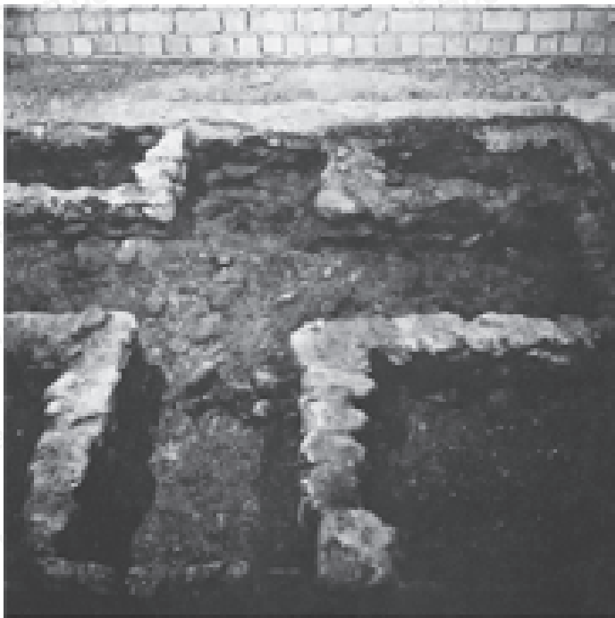
9 Reichenau-Mittelzell. Klosterwestflügel, beheizbarer Saal; nachträglich eingebaute Heizung (wohl 11. Jh.).
