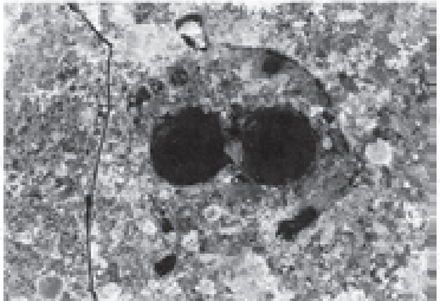
3 Pontigny, Brunnenbecken, Ansicht und Detail: doppelte Bohrlöcher für Steig- und Fallrohr (Dr. T. Kinder).
