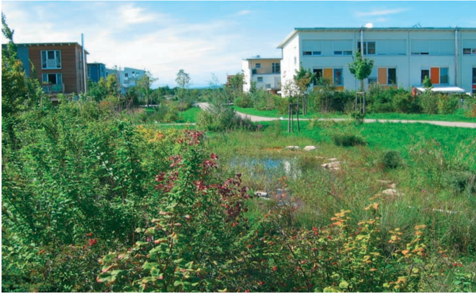
Abbildung 3: Versickerungsteich als naturnahes Gestaltungselement im Siedlungsbereich
